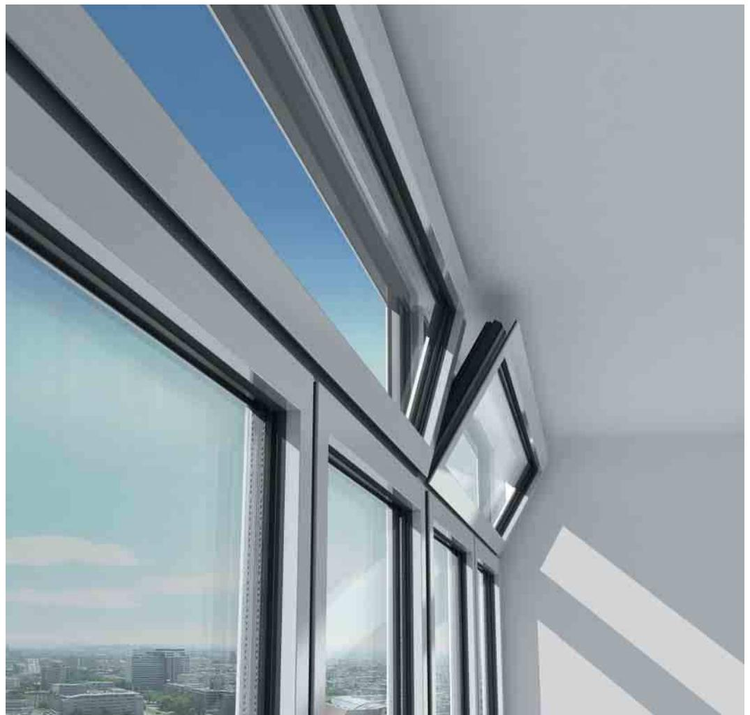
Anstelle von Riegelstangen im Flügelrahmen erfolgt die Verriegelung beim Schüco TipTronic Beschlag durch einzelne Antriebe. Die Kippfunktion wird durch einen separaten Kettenantrieb unterstützt. Der mechatronische Beschlag verbindet die Bedienung in Echtzeit mit den Möglichkeiten der Gebäudeautomation.
